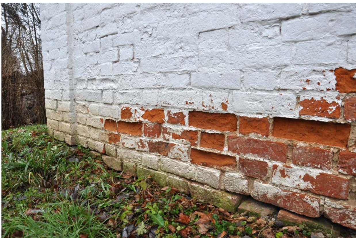
Фрагмент кирпичной кладки на северо-восточном фасаде. Фото Н.Д. Ивашовой, 2019 г.
