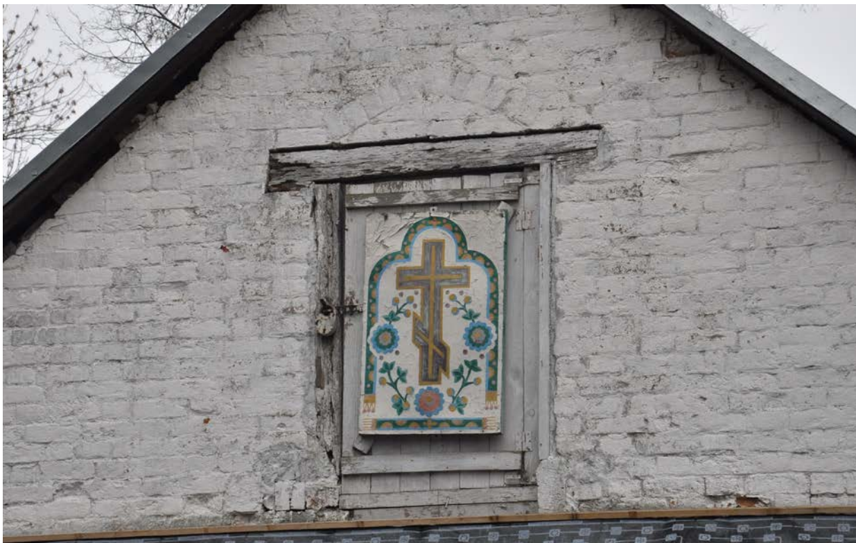
Проём чердачного окна на северо-восточном фасаде. Фото Н.Д. Ивашовой, 2019 г.
