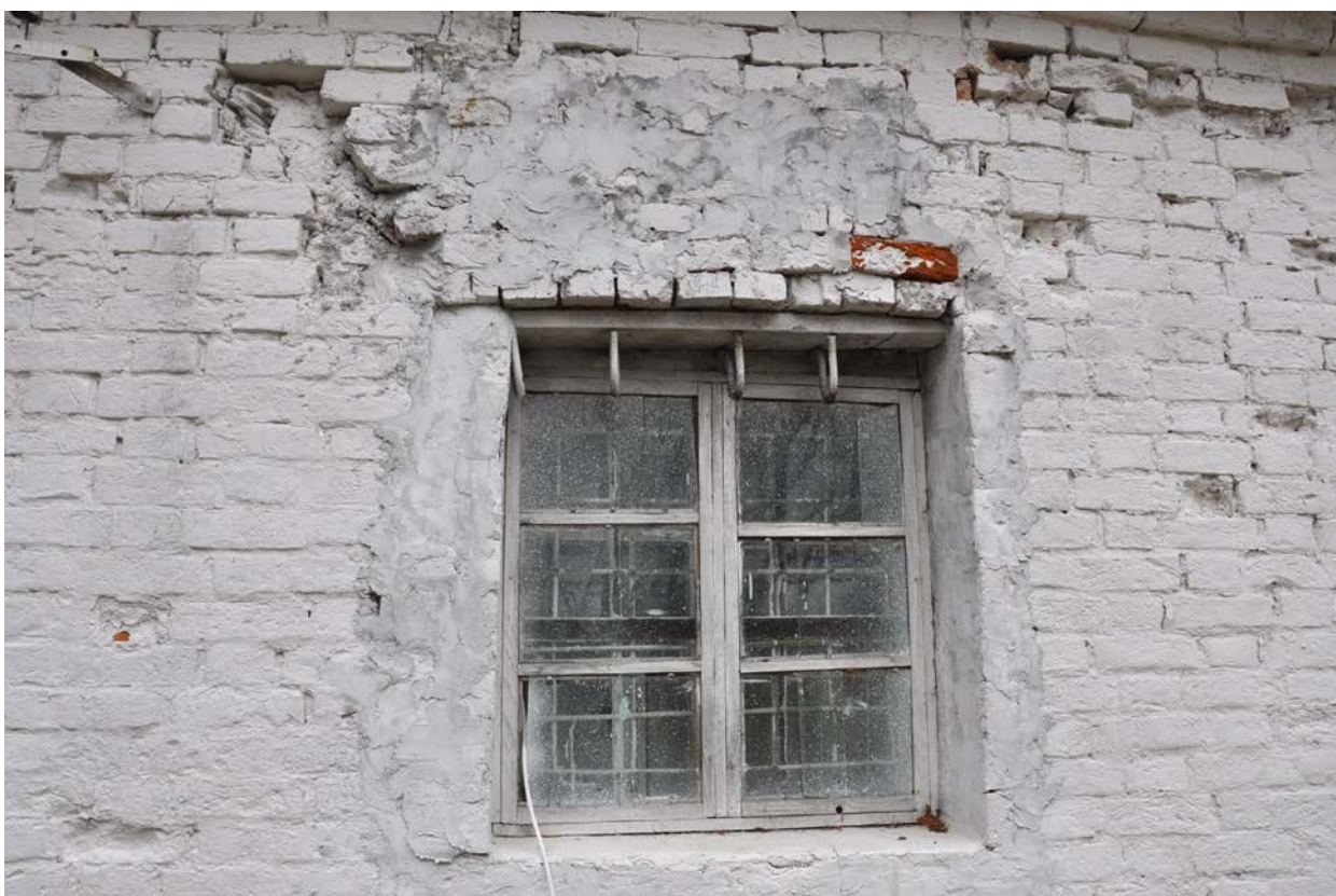
Оконный проём на северо-восточном фасаде. Фото Н.Д. Ивашовой, 2019 г.
