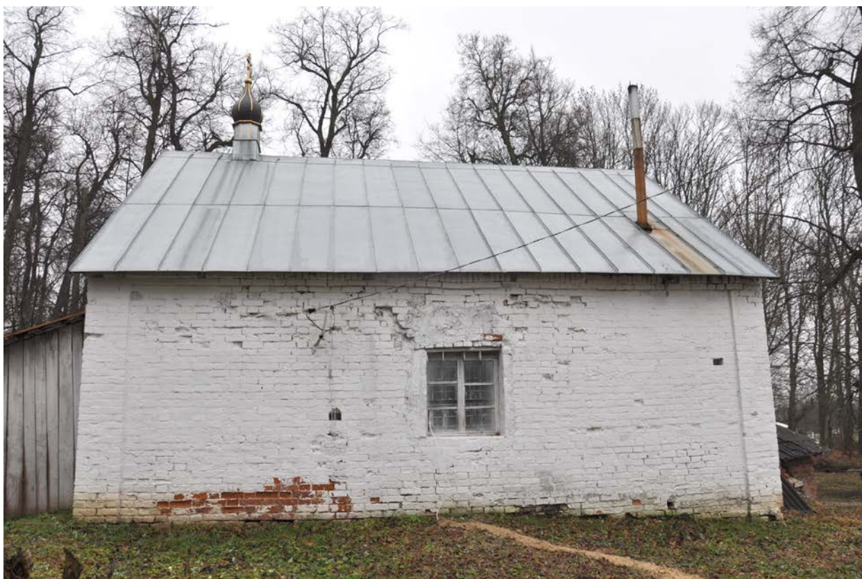
Северо-западный фасад. Фото Н.Д. Ивашовой, 2019 г.
